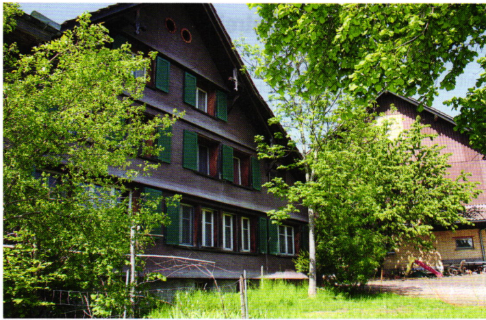
Zum Betrieb gehören das Wohnhaus, eine Scheune mit Stall und Umschwung.
